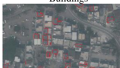
(d) Roof Tops of Small Houses
